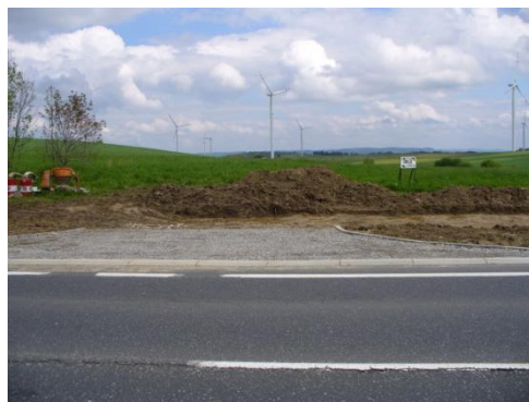
Fot. 4. Zrealizowany wjazd na teren objęty Projektem Planu (widok z drogi krajowej)
