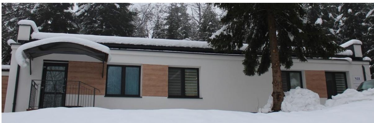
Budynek Ośrodka Zdrowia w Rymanowie-Zdroju po termomodernizacji.
