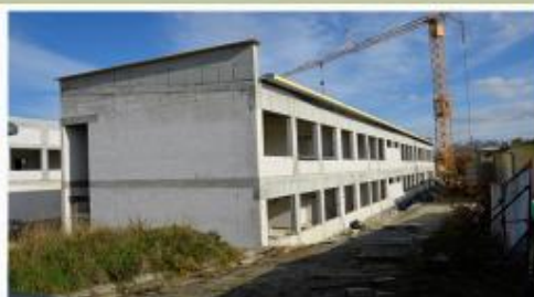
Budowa nowej szkoły
